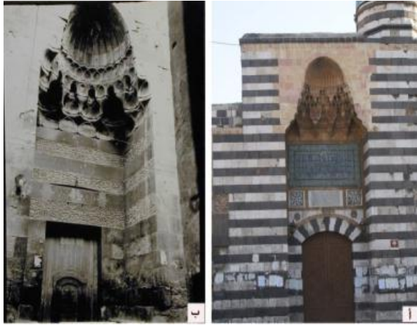
لوحة (٦): أ- مدخل جامع السنانية بدمشق ٩٩٩هـ / ب- مدخل المدرسة الظاهرية بدمشق ٦٧٧هـ / ١٢٧٨م؛ Herzfeld Archive
