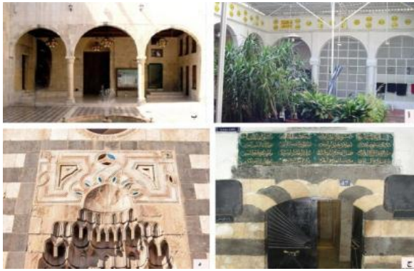
لوحة (١٤): أ- العقود النصف مستديرة بالمدرسة الأحمدية بدمشق ٩٤٤هـ / ١٥٣٨م. ب- العقود النصف مستديرة بالمدرسة الظاهرية بدمشق ٦٧٧هـ / ١٢٧٨م. ج- عقد من صنجات متداخلة بالمدرسة الاسماعيلية بدمشق ١١٣١هـ / ١٧١٩م. د- واجهة المدخل بالمدرسة الجمققية بدمشق ٨٢٢هـ / ١٤١٩م.
