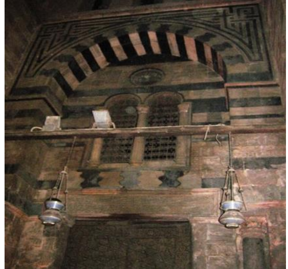
صورة (1) توضح المدخل مجموعة قلاوون ونلاحظ قمريتين مطولتين يعلوهما قمرية مستديرة. وتنتضح القنديلية البسيطة أعلى الباب.
