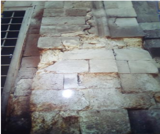
صورة (18) توضح مدى حالة تلف وتراكم الاملاح علي السطح.
