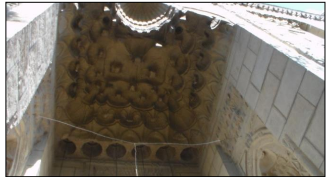
(لوحة ٢٣) سقف حجر المدخل
