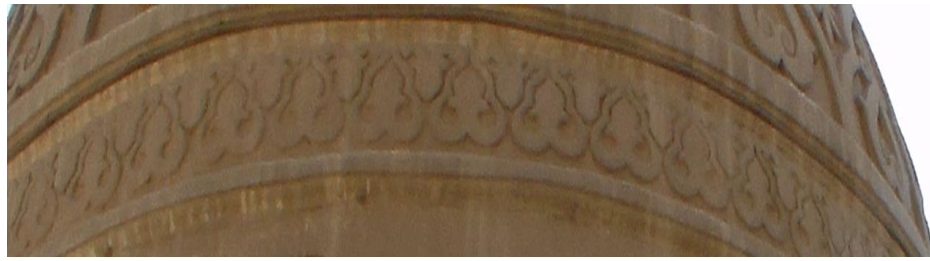
(لوحة ٨٨) منطقة الانتقال ورقبة القبة من الخارج
