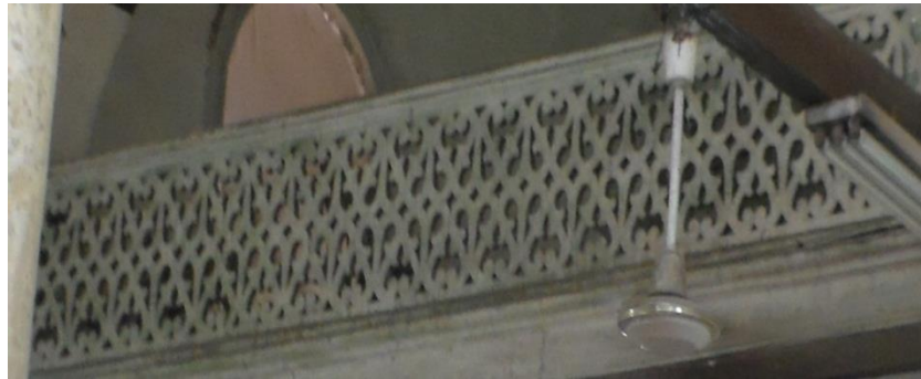
(لوحة ٦٤) دكة المبلغ بواجهتها الجنوبية الشرقية
