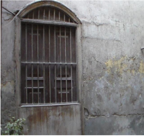
(لوحة ٤٠) النافذة التي بالطرف الجنوبي الواجهة الجنوبية الغربية
