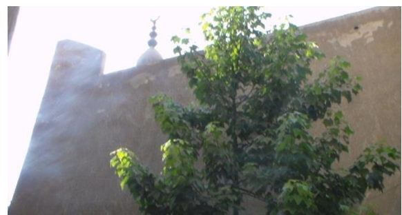
(لوحة ٤٣) الجانب الجنوبي من الواجهة الجنوبية الشرقية موضحاً الميل الذي بها من أعلى
