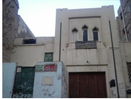
(لوحة ١٠٢) واجهة مبنى الأوقاف
